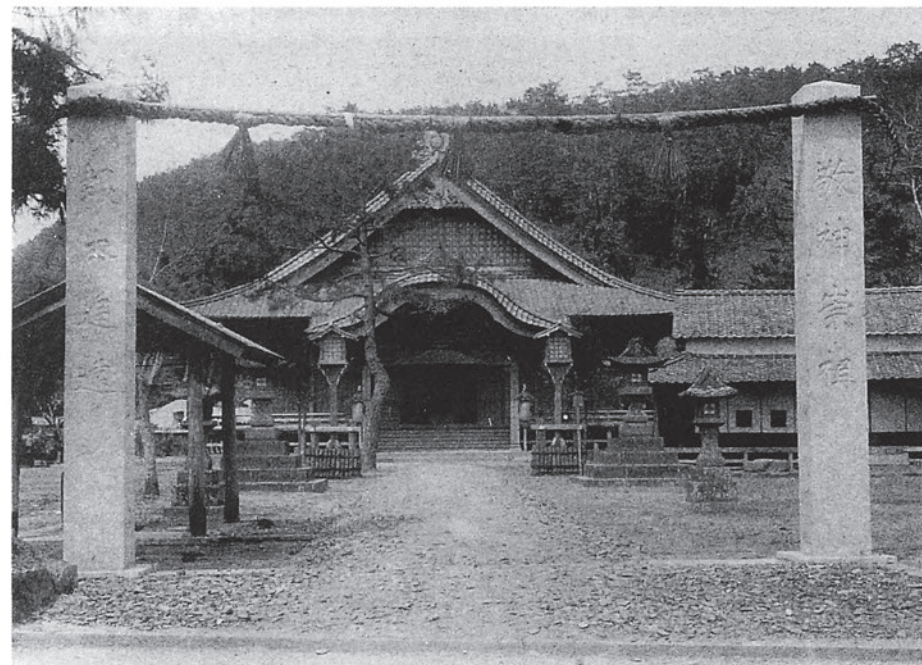
改築工事、第一期工事終了直後の祖霊社（昭和2年）① 正面
